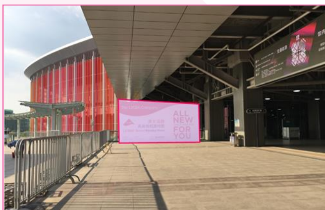
C33A 广告板 – 登录厅平台入口
