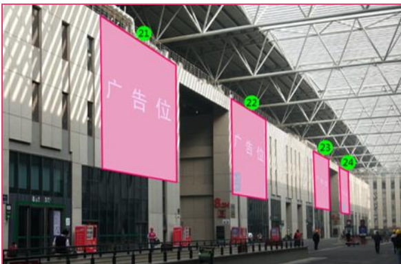
B50 展馆外墙广告 - 二层(16米层)车道
